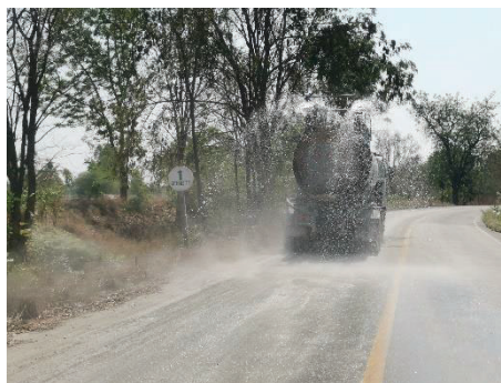
รูปที่ 2-15: การฉีดพรมน้ำบนเส้นทางขนส่งแร่ ช่วงที่ผ่านชุมชน
